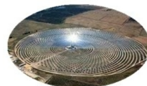
YTFS 配电产品全面服务于美国加州巴斯托光伏电站、德州海军基地等军用设施
