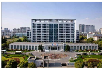
中铁四局建设
